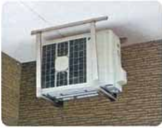
⑤ アルミ天井吊金具使用時
