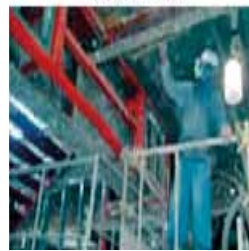
半湿式吹き付け ロックウール
