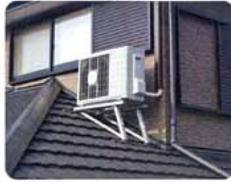
② アルミ屋根直角置台使用時
